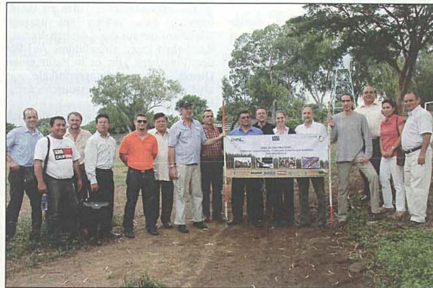
Auf einem etwa 5000 m 2 großen Grundstück wird das Technologiezentrum in Holzbauweise unter der Projektleitung des Rosenheimer Absolventen Dipl.-Ing. (FH) Stefan Losen errichtet. Foto: Hochschule Rosenheim
